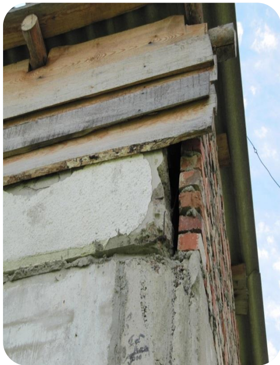
Аварийное разрушение здания котельной
