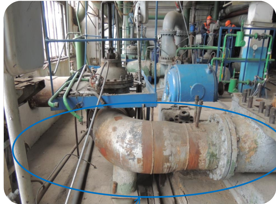
Неудовлетворительное техническое состояние паропровода
