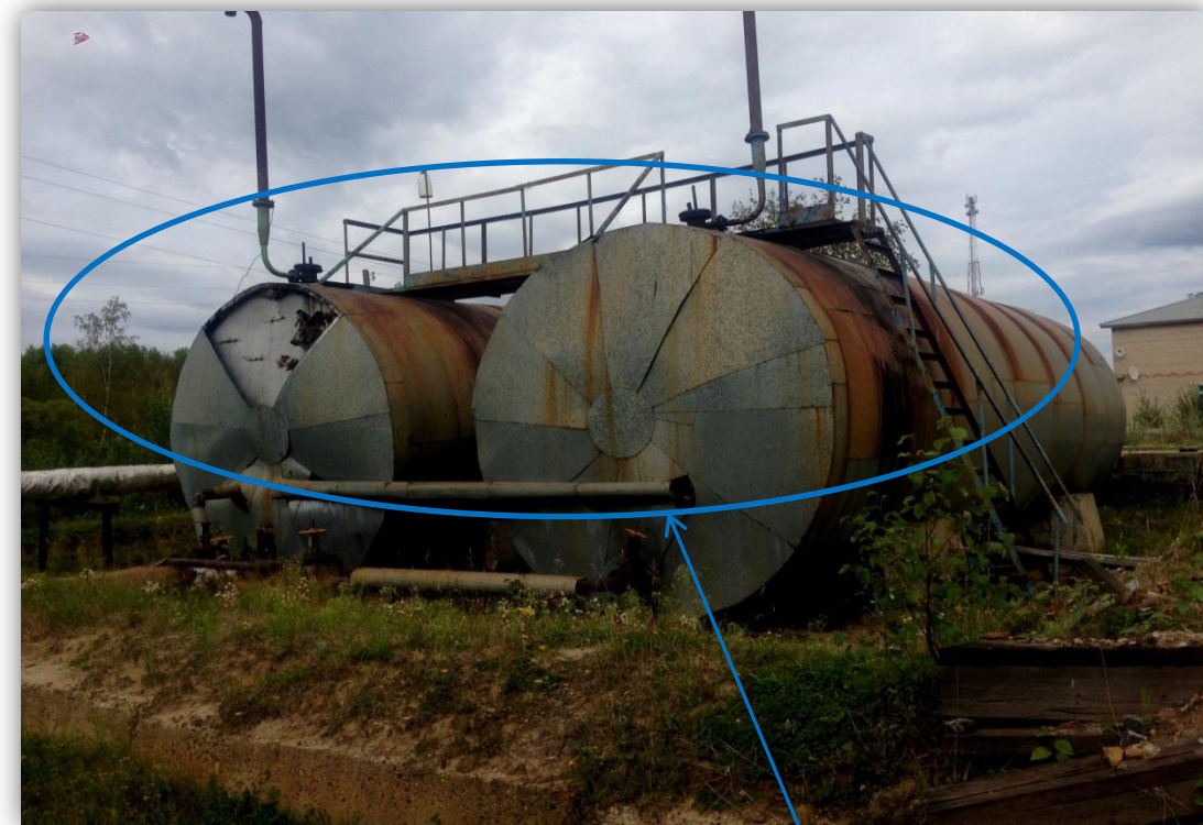
Не проведено обследование резервуара для хранения жидкого топлива котельной
