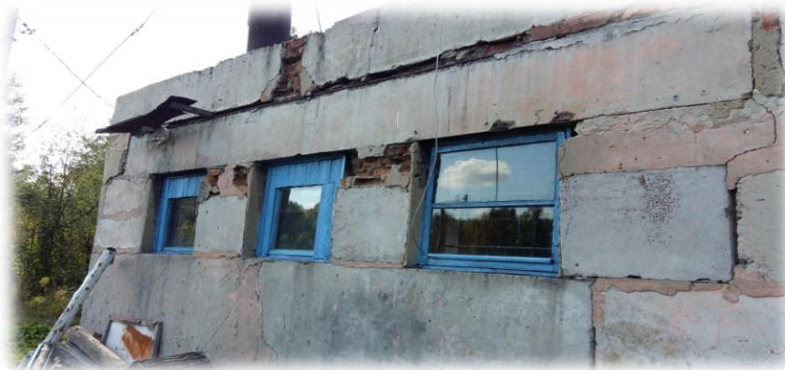
Аварийное разрушение здания котельной
