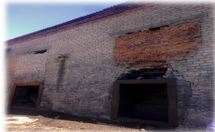
Аварийное разрушение здания котельной
